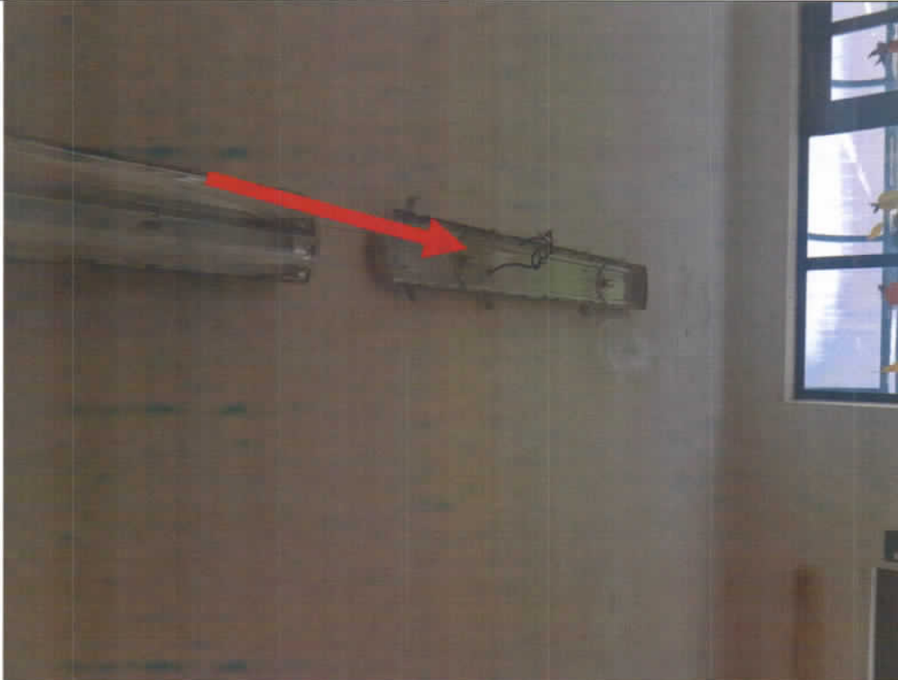
Ripristino della plafoniera.
