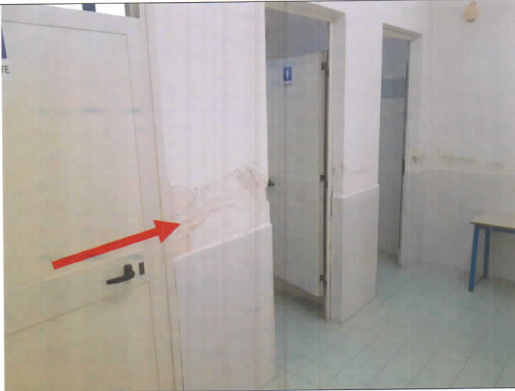
Ripristino del relativo intonaco.
