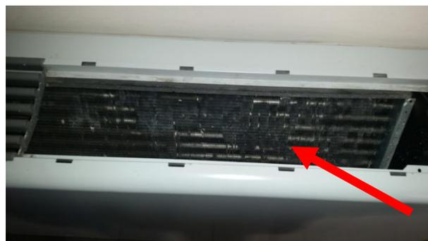
Alcuni termoconvettori, inoltre, come già segnalato in precedenza, hanno le **griglie** completamente **staccate o rotte**, lasciando il **vano interno aperto ed accessibile**.
